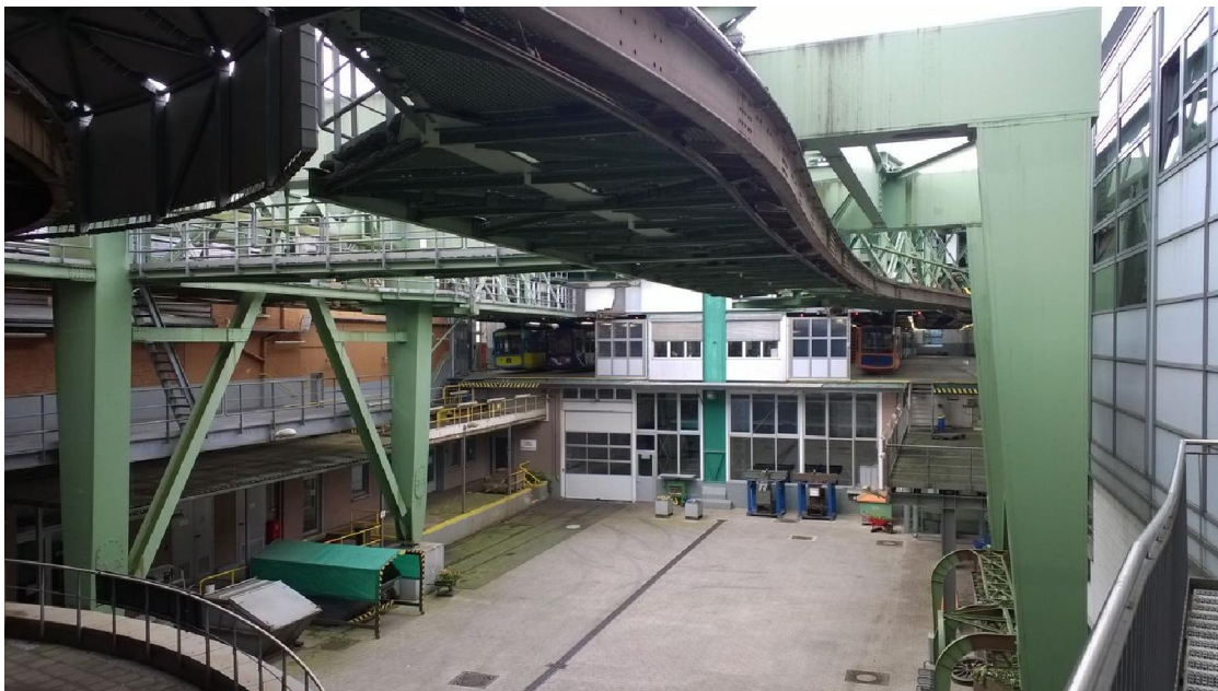
Foto 6 - Wuppertal: il deposito-officina principale della Schwebebahn a Vohwinkel, visto dalla stazione
