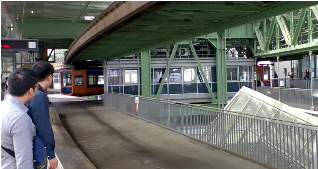
Foto 8 - Wuppertal: la manovra d' inversione di un treno al capolinea di Vohwinkel
