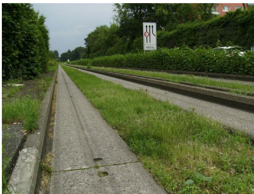
Foto 17 - Essen: particolare della via di corsa del sistema O-bahn alla fermata Krampferstr.
