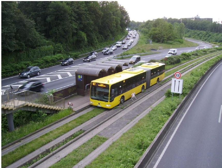
Foto 18 - Essen: Il tratto di linea attrezzato con il sistema O-Bahn nel mezzo dell'autostrada A40
