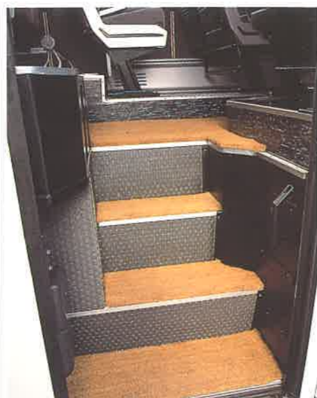
Gradini con rivestimento antiscivolo.
