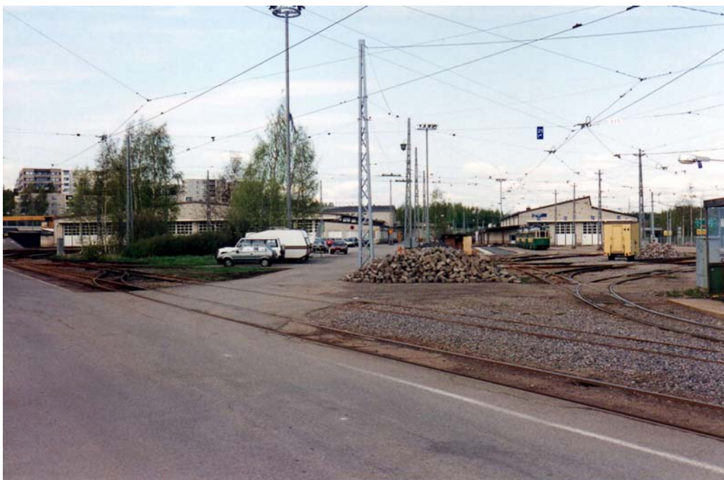
Foto 13 - Deposito di Koskela
