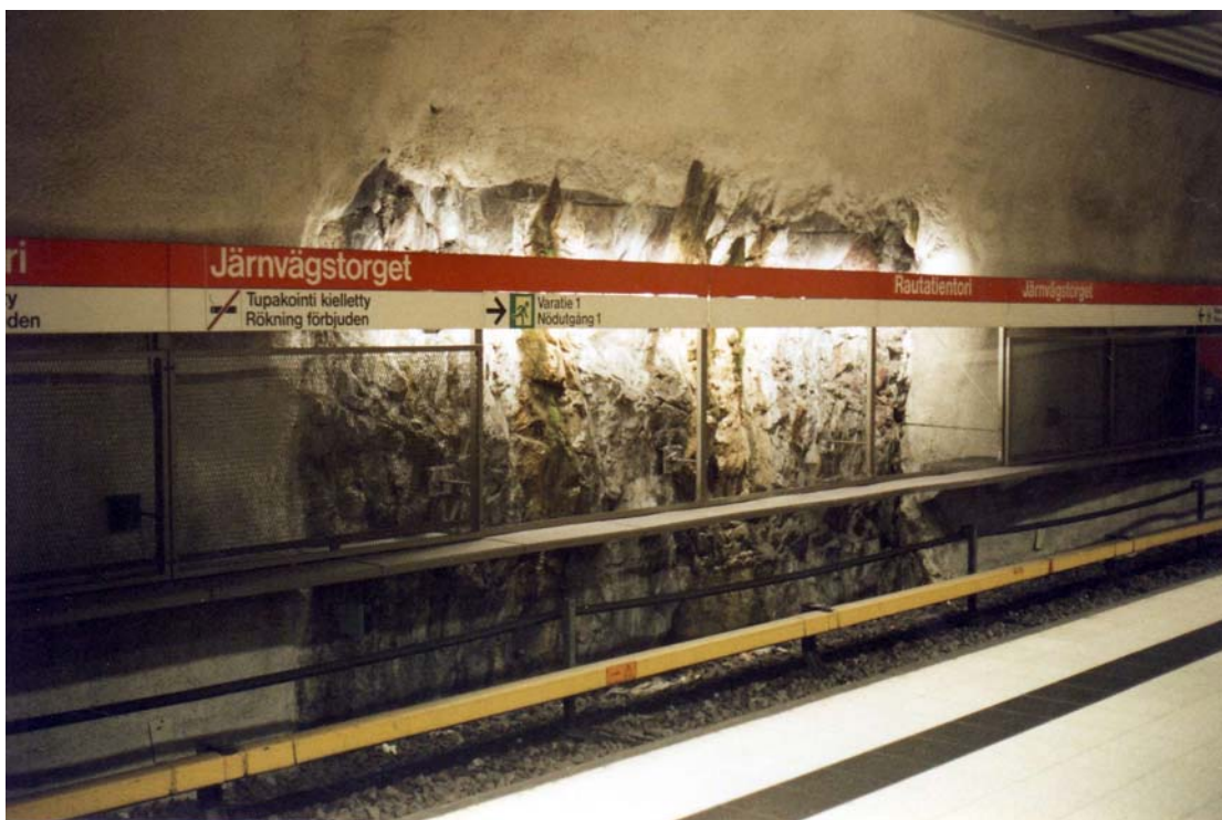
Foto 18 - Stazione Rautatientori: un tratto di roccia viva lasciato scoperto
