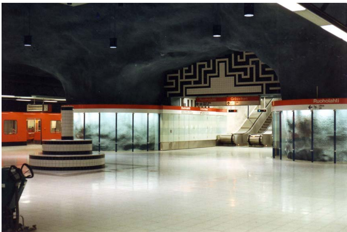
Foto 19 - Stazione Ruoholahti: la roccia qui è stata interamente ricoperta dal cemento e verniciata
