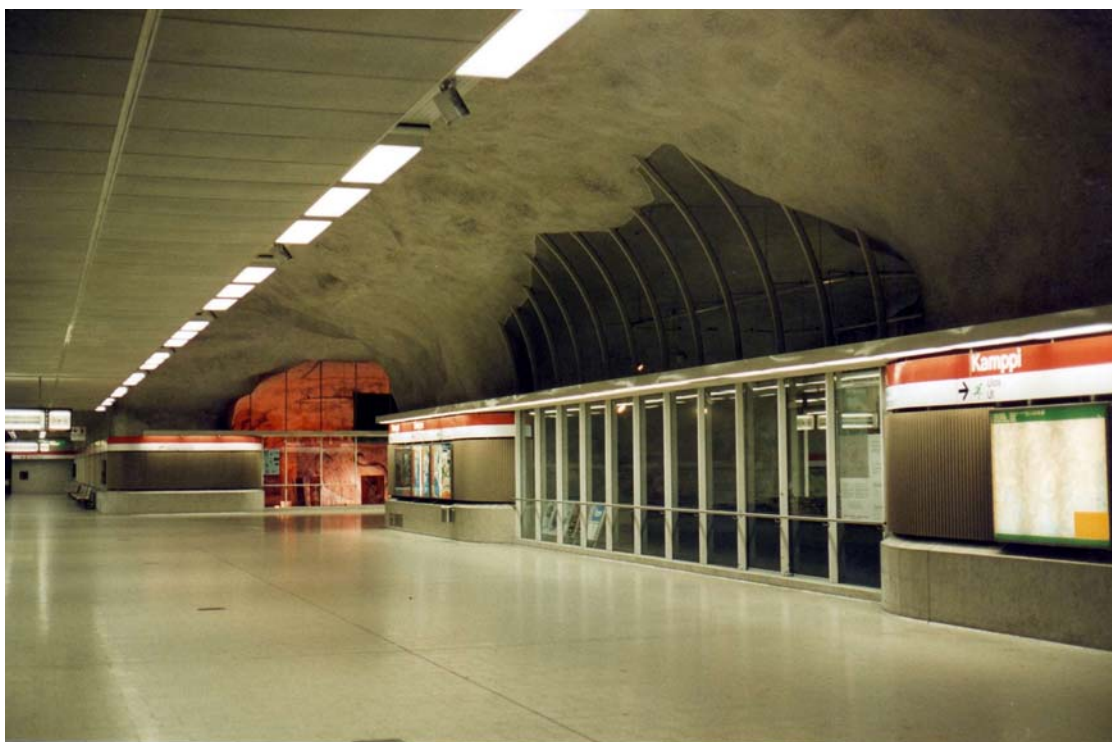
Foto 20 - La stazione Kamppi è la più profonda della linea: anche qui la roccia è ben visibile
