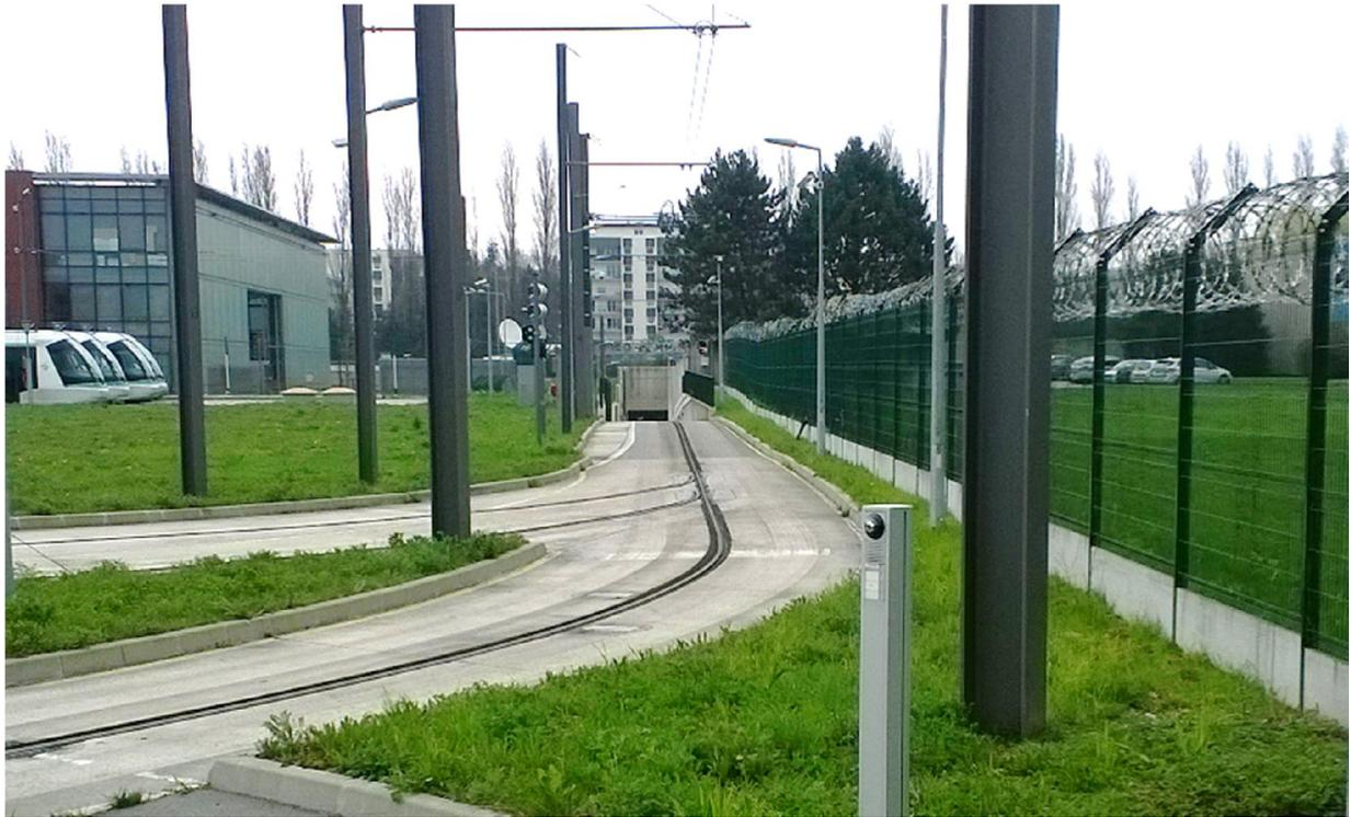
*Foto 11 - Linea T6: al centro il raccordo a via singola tra il deposito e la linea, che sottopassa l'autostrada A86, visto dal deposito - marzo 2017*
