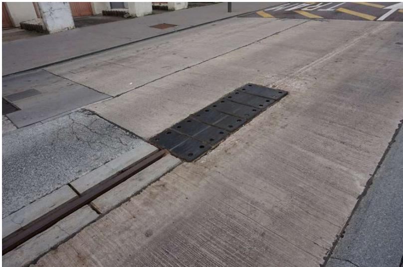
*Foto 59 - Ed uno dei punti di uscita, dove i ruotini guida vengono sollevati ed i mezzi passano dalla modalità vincolata alla guida manuale da parte dell' autista*
