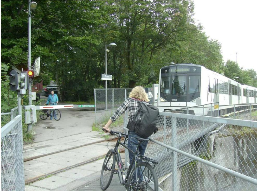
*Foto 24 - Scena impensabile in Italia: un passaggio a livello ciclopedonale con barriere e semaforo, per attraversare una linea metropolitana, con tanto di terza rotaia! Fermata Frøen della linea 1*
