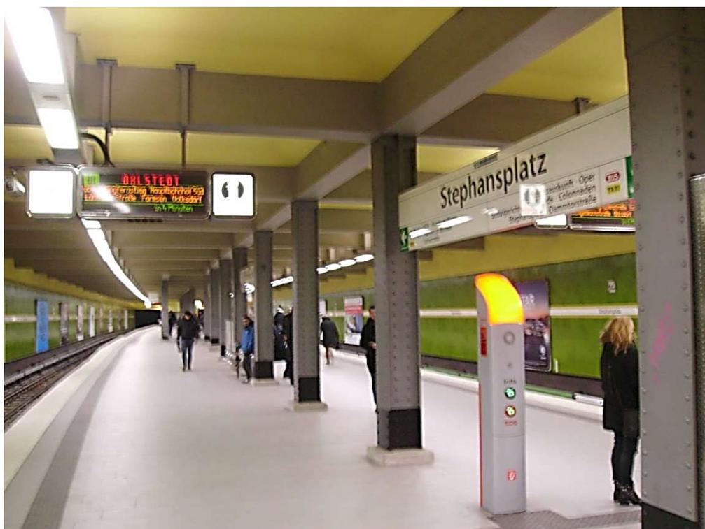
*Foto 8 - Stazione Stephansplatz della linea U1, con la larga banchina centrale ed i pilastri in ferro*
