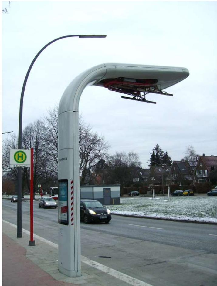
Foto 24 - Uno dei portali forniti da Siemens per la ricarica dei bus Volvo elettrici, qui ad Alsterdorf: si vedono bene le slitte per le due polarità elettriche
